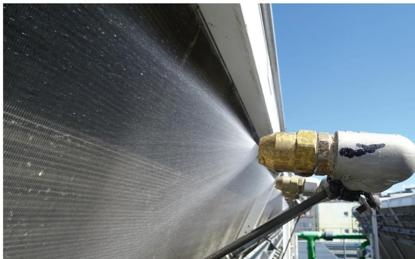
**Besprühungsanlage Ventilator-Kühlturm | © ÖKOTEC Energiemanagement GmbH**
