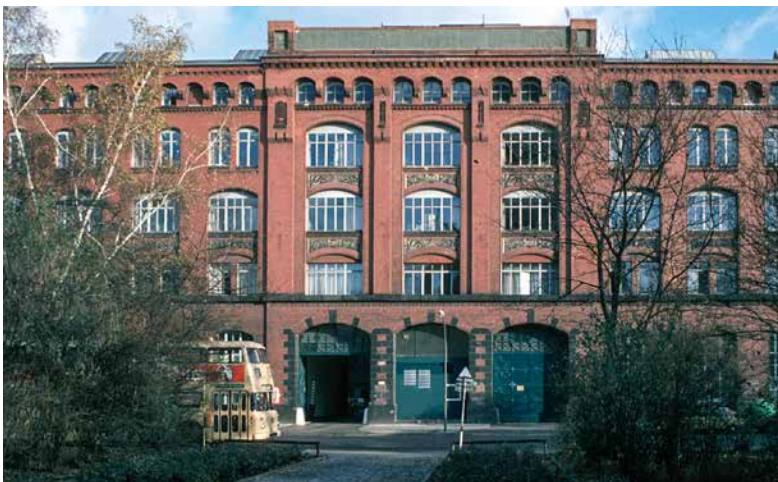
1 / Der Eingang zum Gebäudekomplex in der Ackerstraße 76 in den 1980er Jahren 2–3 / In der Ackerstraße waren Roboter aller großen Hersteller versammelt, etwa von KUKA, Reis Robotics und Manutec.
